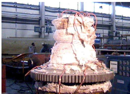
شکل ۱۱. پوشش‌دهی سطح حرارت‌دهی با عایق نسوز.
