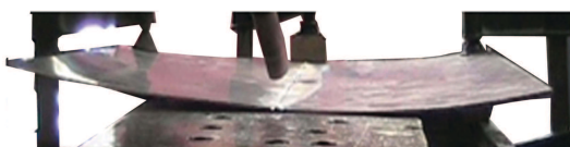
ج) چگونگی قرارگیری قطعات در کنار یکدیگر بعد از خال جوش ها و قبل از آغاز جوشکاری.
